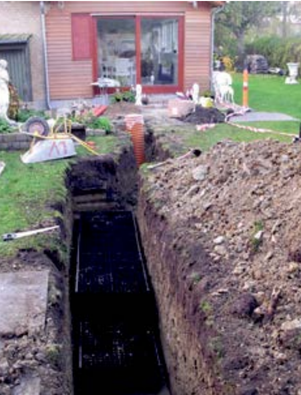
En faskine etableres (foto: Spildevandscenter Avedøre)
