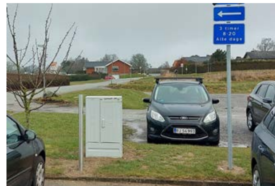
Ladestander og plads til 2 el-biler er ved at blive etableret
