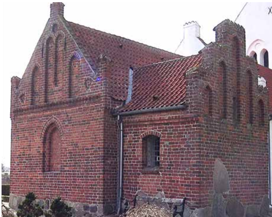
Gavlene på både sakristi og kor er udsmykket med blændinger og kamtakke
